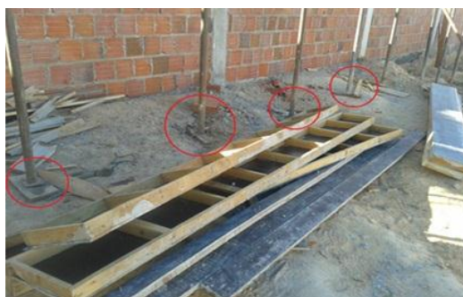
Figura 2 - Uso de aparas de madeira na base de andaimes
