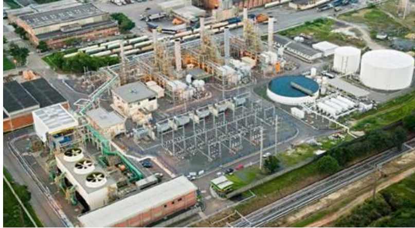
Figura 1 – Visão panorâmica da Unidade Termelétrica Rômulo Almeida (BARRETTO, 2010)
