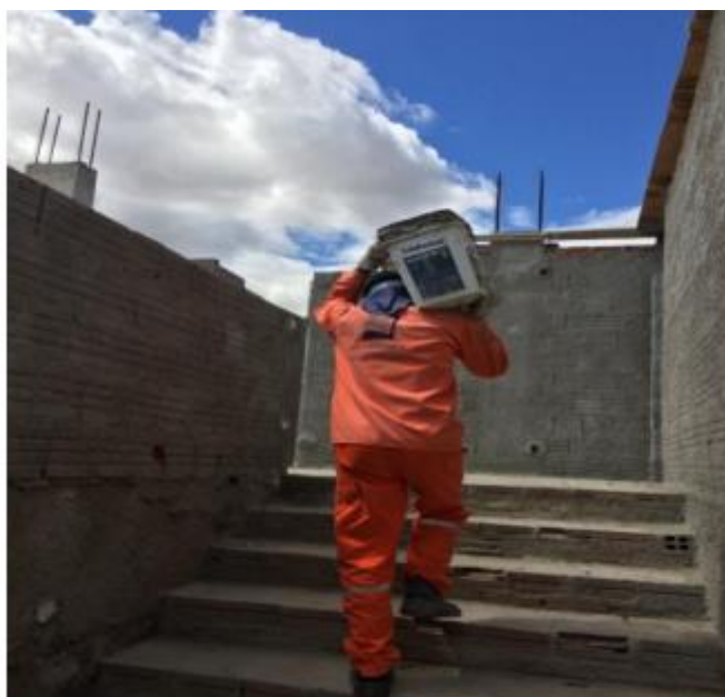
Figura 3 – Pedreiro subindo com os baldes de massa de concreto pela falta do carretel na Obra
