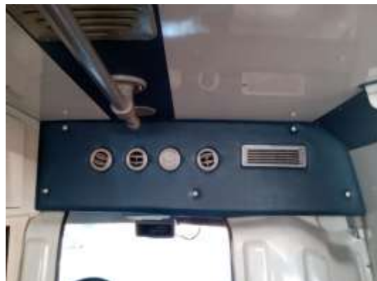
Figura 6 - Estrutura de Ventilação
