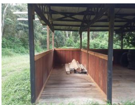
Figura 4 – Depósito de Resíduos Perigosos – Setor de Lâmpadas Fluorescentes Pesquisa de campo, 2017
