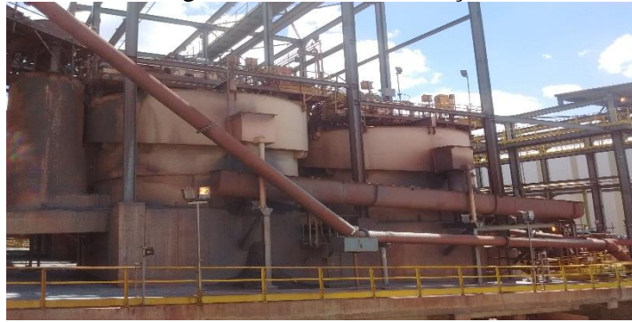
Figura 6 - Célula de Flotação
